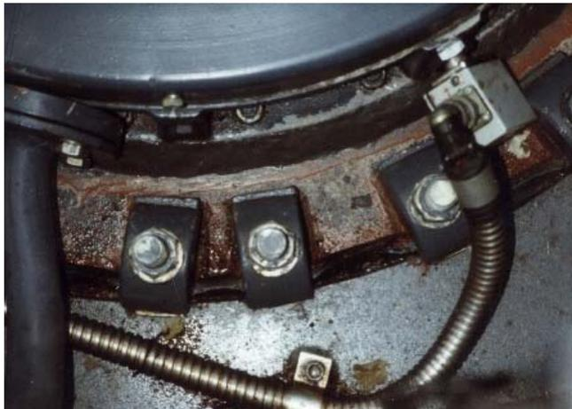
Am Stufenschalter eines Großtransformators drang Transformatoröl durch mehrere Risse zwischen Deckel und Lastumschaltergefäß. Die Instandsetzung erfolgte nach dem direct-MM-bonding Verfahren mit MM-metall oL-StahlKeramik und Härter rot und nachfolgend Härter gelb.
