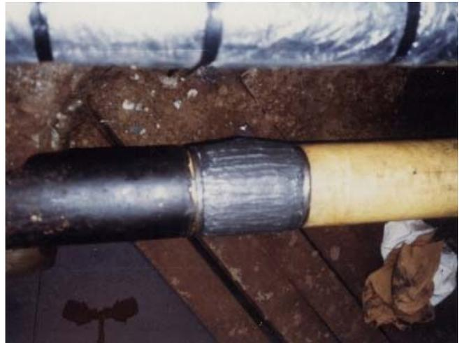
Eine Leckage in einer 154 kV P.O.F. Isolationsleitung wurde mit MM-metall oL-StahlKeramik und Härter rot nach dem direct-MM-bonding Verfahren abgedichtet. Gleichzeitig wurden Korrosionsschäden an der Leitung mit MM-metall SS-Stahl, flüssig und Härter gelb, flüssig behoben. Öldruck 14 bar, Durchmesser der Leitung 300 mm, Ölqualität Polybdenum
