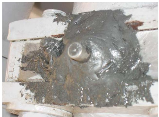
Ein beschädigter Transformator eines Stahlwerks wurde durch die Verwendung von MM-metall oL-StahlKeramik und Härter gelb instand gesetzt.
