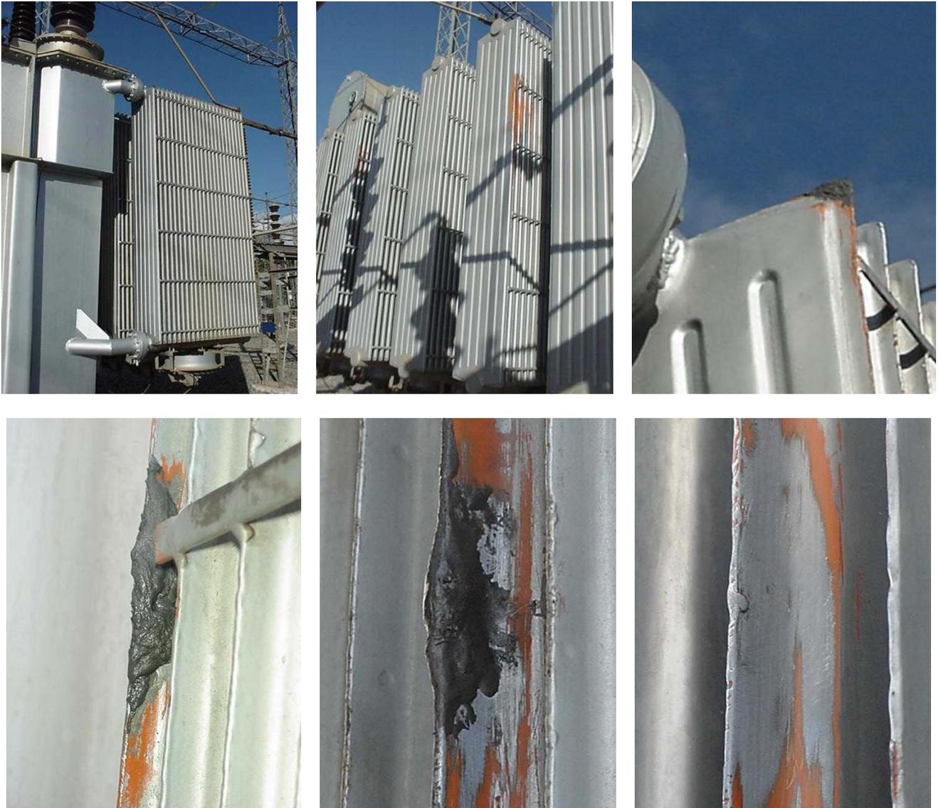
Verschiedene verschlissene Stellen an einem Transformator eines Stahlwerks wurden mit MM-metall oL-StahlKeramik und Härter gelb abgedichtet.
