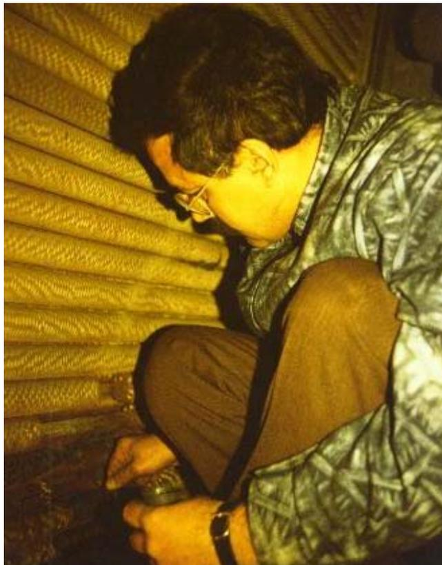
Abdichtung einer Kühlwassereinrichtung aus Stahl ohne Stillstand der Anlage. Schadensursache war Materialermüdung. Die Reparatur erfolgte mittels MM-metall UW und Härter UW3 mit MM-Gewebeband (Glasfaser).
