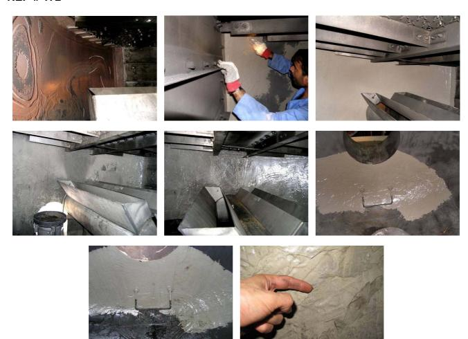
Ein in einer Raffinerie befindlicher Gaswäscher zur Reinigung von saurem Erdgas wies aufgrund der schweren Beanspruchungen in mehreren Bereichen erhebliche Korrosionsschäden auf. Dort wirken hohe Arbeitstemperaturen (140 °C), Druck (3 bar) und eine Reihe von Chemikalien (Amin MDEA, H2S, CO2, O2, diverse Säuren, ...). Mit MultiMetalls Beschichtungswerkstoff Ceramium® CH / Härter CH1 wurden hervorragende Ergebnisse erzielt. Weitere detaillierte Infos finden Sie auf
