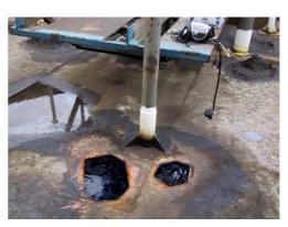
Alternativ zu aufwendigen konventionellen Reparaturverfahren (z.B. Schweißarbeiten) kann beim Reparaturverfahren mit PolymerMetall® an Schwimmdachtanks ggf. auf ein kostspieliges Ablassen der im Tank beinhalteten Flüssigkeit verzichtet werden. MM-metall oL-StahlKeramik kann auf problematischen Untergründen (Kontamination durch Öle, Kraftstoffe etc.) appliziert werden. Der zusätzliche Einsatz des flexiblen Werkstoffs MM-Elastomer wirkt Spannungen entgegen.
